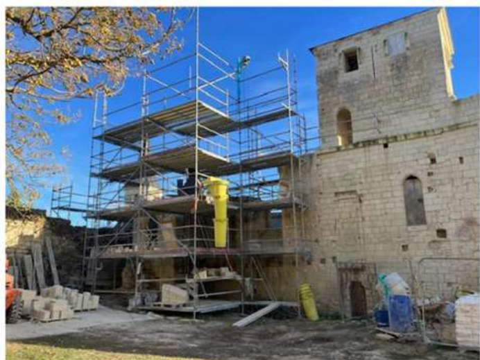
Tourelle d'escalier : présentation des travaux et de l'arcature de baie
