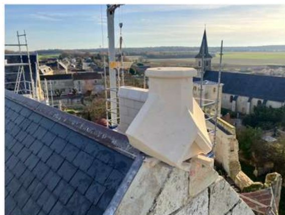
Rondelis Ouest : pose de couronnement pour caler la pente du versant Sud.
