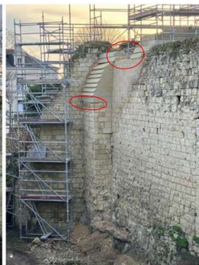
Enceinte Est – contre fort achevé : demande MOA : « fermer la brèche » + demande MOE : vieillir le raccord en amortissement du glacis
