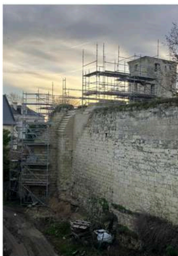
Enceinte Est – contre fort achevé : demande MOA : « fermer la brèche » + demande MOE : vieillir le raccord en amortissement du glacis
